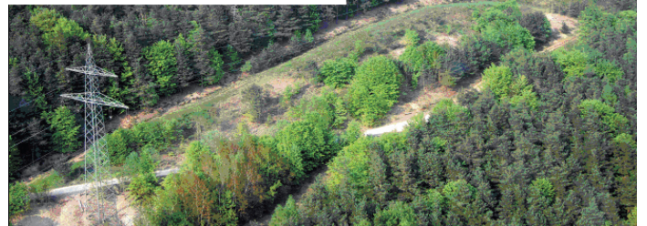
Bewuchs im Trassenkorridor einer Freileitung
